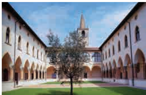
Chiostro dell'Incoronata a Martinengo.
